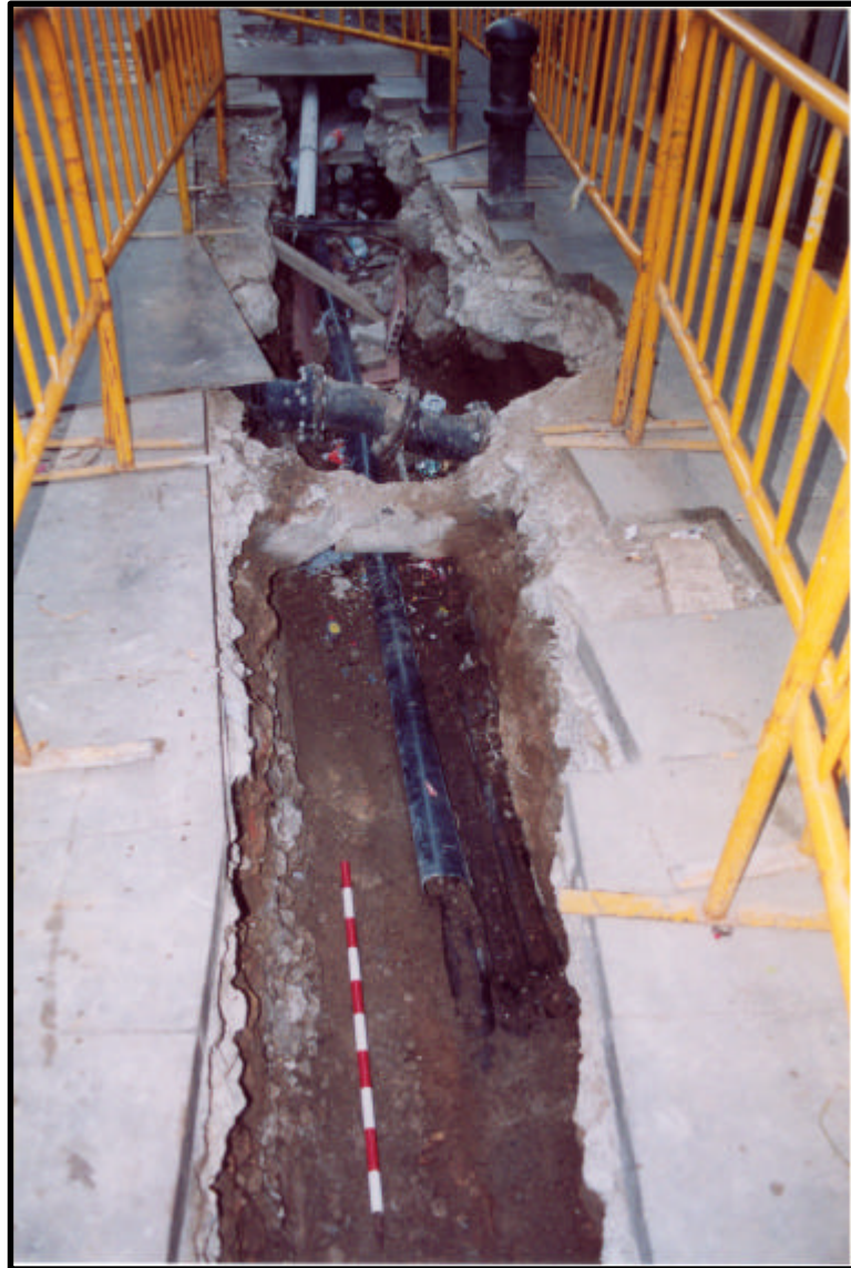
Fot.2. Vista general de la rasa en el moment d'iniciar els treballs
