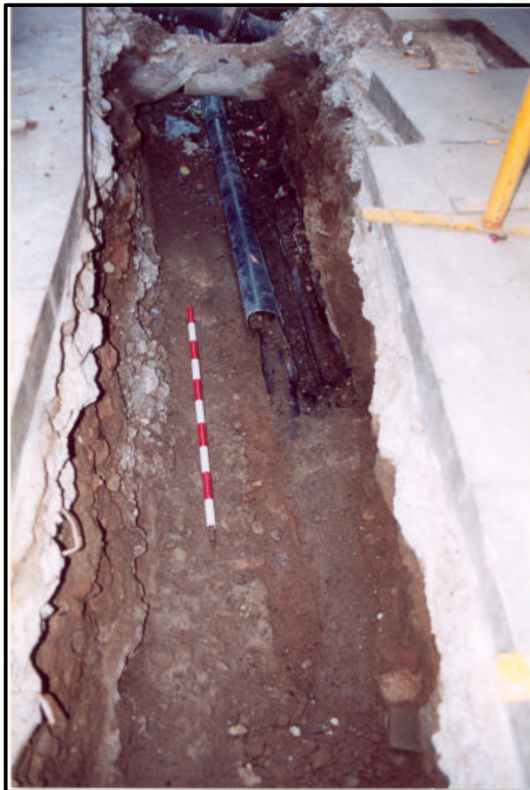
Fot.1. Vista general de la rasa en el moment d'iniciar els treballs
