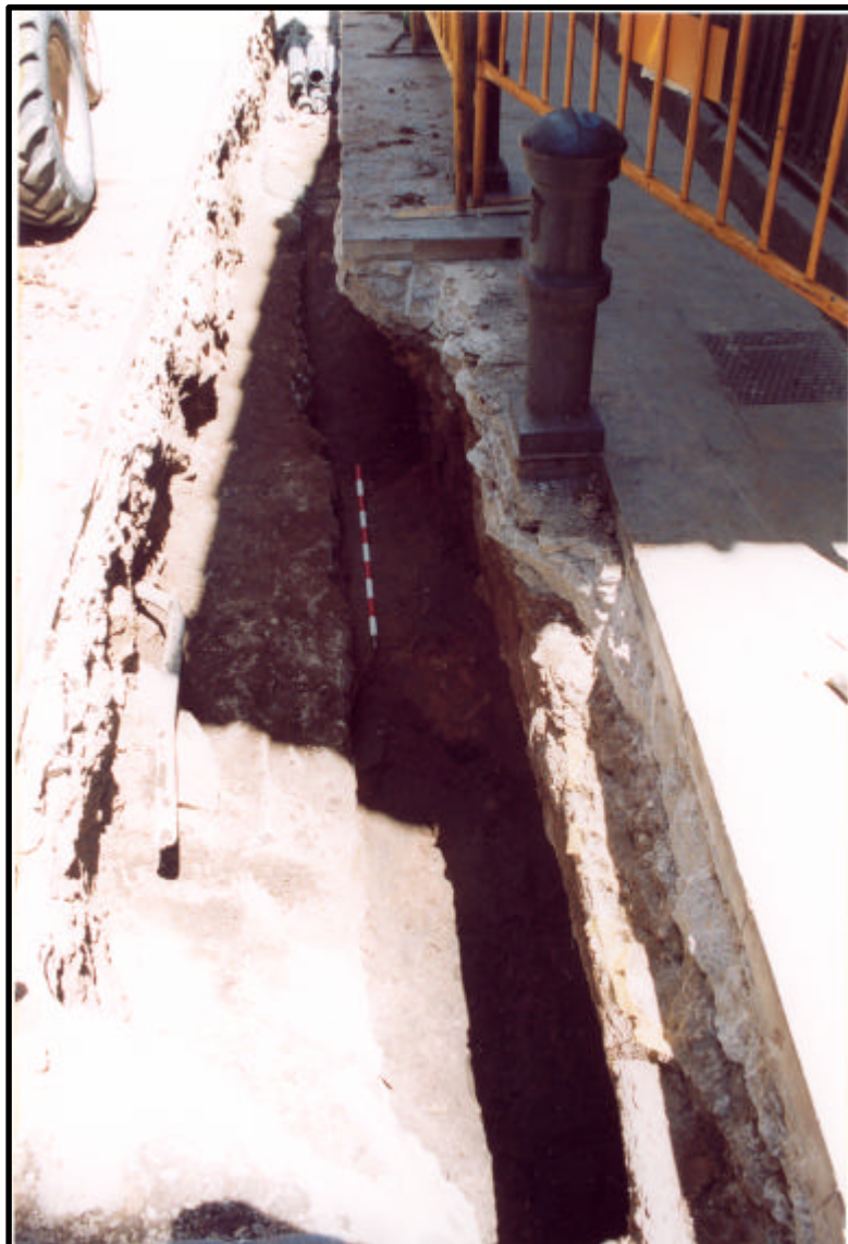
Fot..5. Vista general del tram final de la rasa
