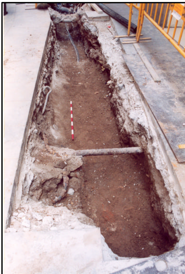
Fot.2. Vista general de la rasa amb la UE 3
